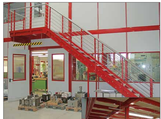
Beispiel für eine Lagerbühne mit Kabinen auf und unterhalb der Bühnenkonstruktion
